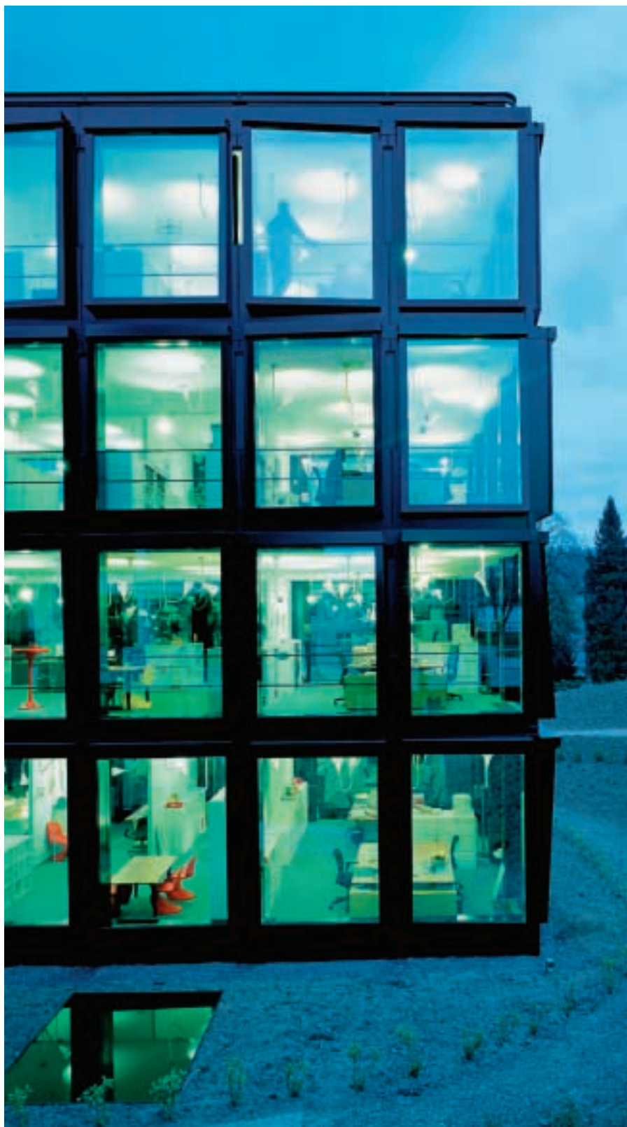
Projekt Helvetia Patria Versicherung Hauptsitz St. Gallen: Umfangreiche Gebäudeautomation gewährleistet den Minergie-Standard. Fotos HPV
