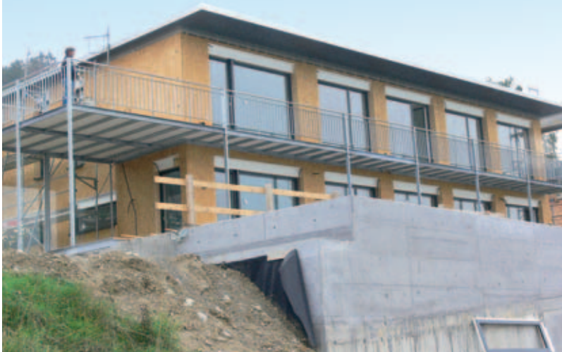
Das EFH Meier in Eschlikon vor den Verputzarbeiten (Fotos: BUS-House)
