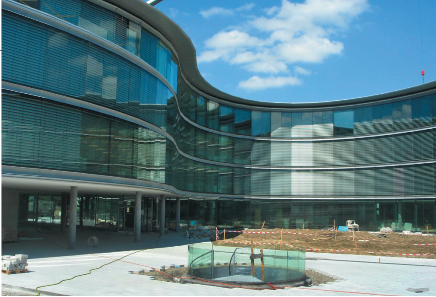
Neubau der Firma Swarovski in Männedorf
